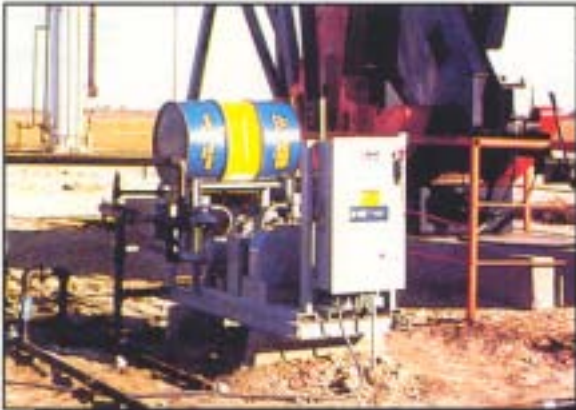
REDUCCION DE CONTRAPRESION EN EL CABEZAL DEL POZO
